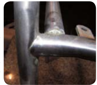
Tubos soldados por soldadura amarilla, tipo 641
