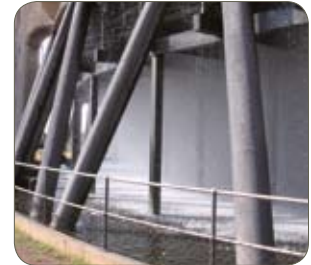
Tipo 1.4003/ 410, torre de refrigeración, Sudáfrica
