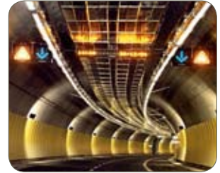
Tipo 1.4016/430, pintado, Túnel de Monte Mario, Centro Inox, Italia
