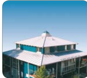
Tipo 1.4510/430Ti (técnica de cubierta estanca), Ugine & Alz, Alemania.
