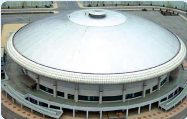
Cubierta de gimnasio, tipo 445, Corea del Sur
