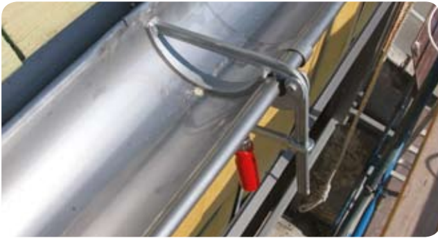
Unión de canalones mediante adhesivo 430 y revestido de estano.
