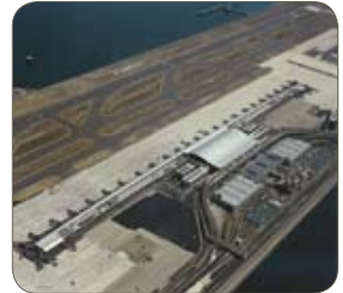
Tipo SUS447J1, edificio de la terminal del aeropuerto Kan- sai (arquitecto Renzo Piano), JSSA, Osaka, Japón
