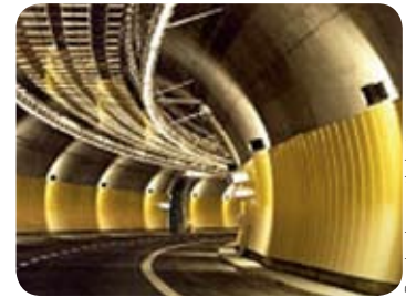
Panels de revestimiento, tipo 430 revestido, Italia.
