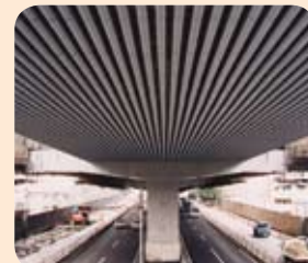
Paseo elevado con estructura inoxidable, Japón
