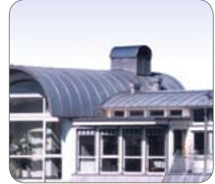
Tipo 430Ti (técnica de cubierta estanca), Ugine & Alz, Austria
