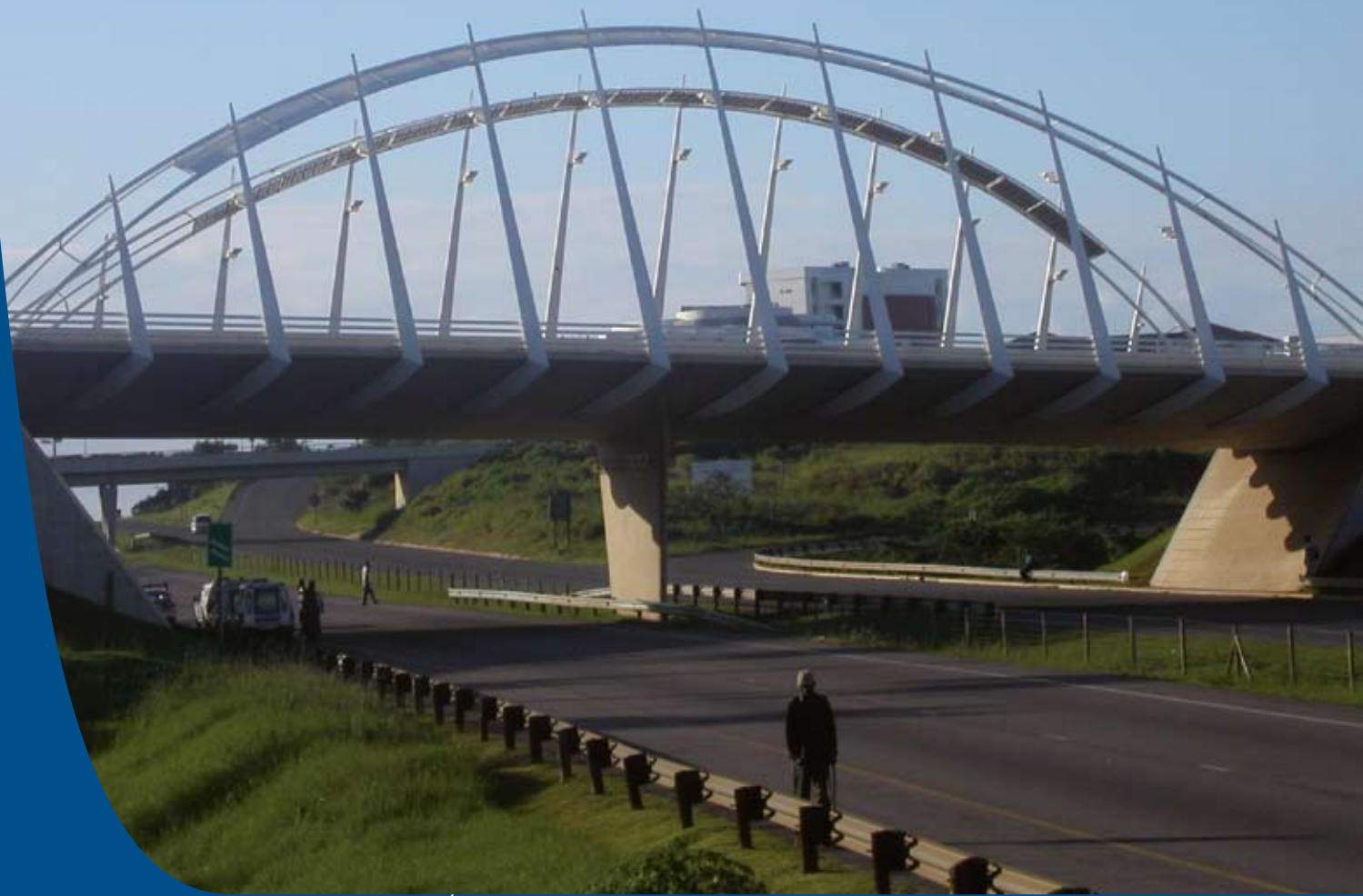
PUENTE SOBRE AUTOPISTA CON ESTRUCTURA DE ACERO INOXIDABLE FERRÍTICO PINTADO. DURBAN (SUDÁFRICA).
